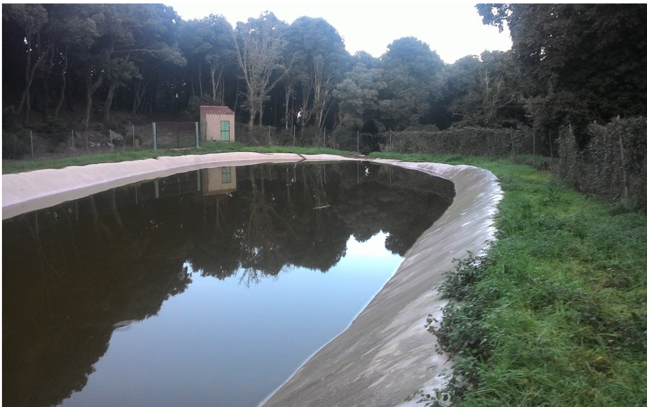
Fig. n. 13 – Punto di scatto n. 2 – stato attuale
