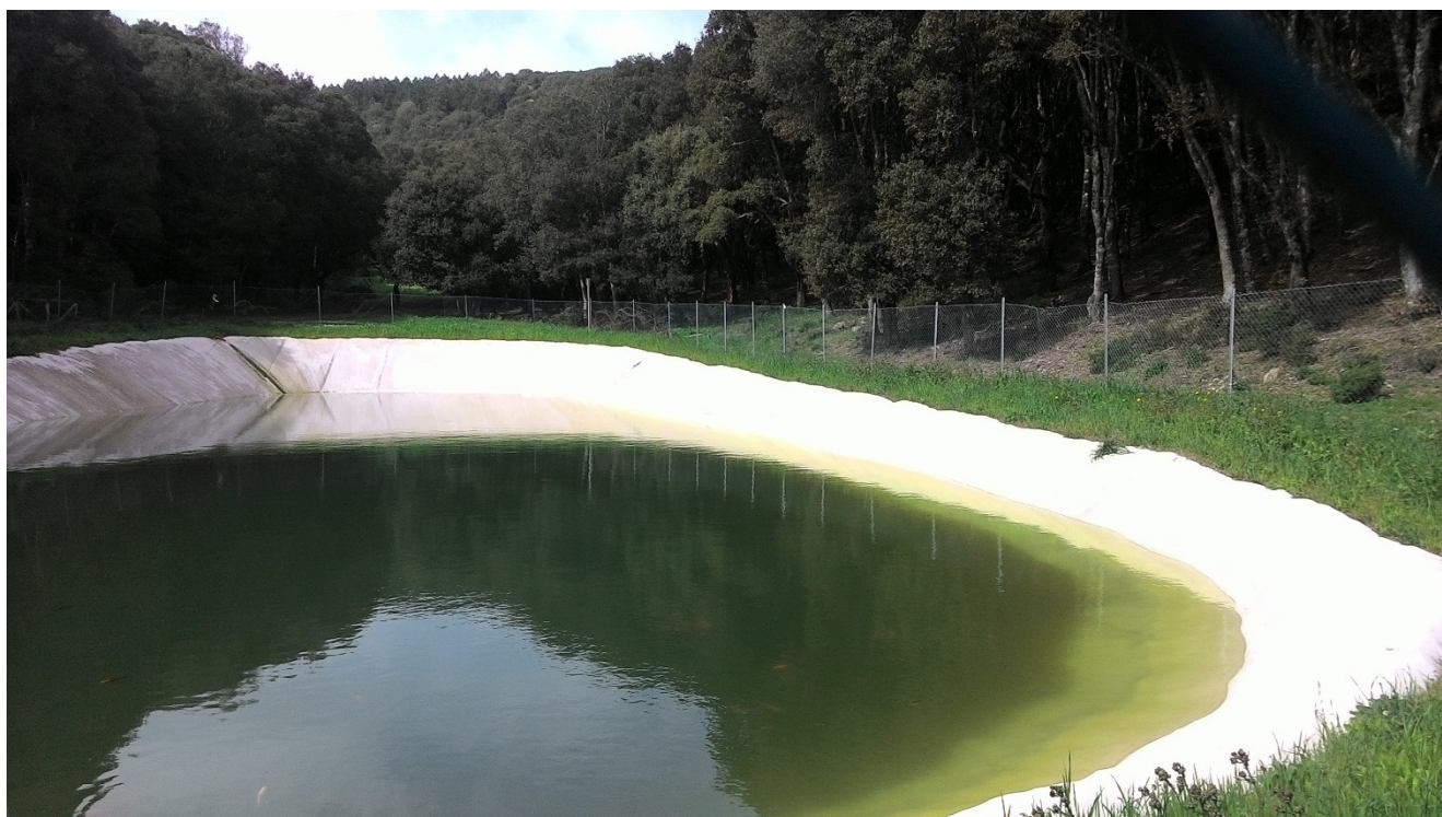
Fig. n. 11 – Punto di scatto n. 1 – stato attuale
