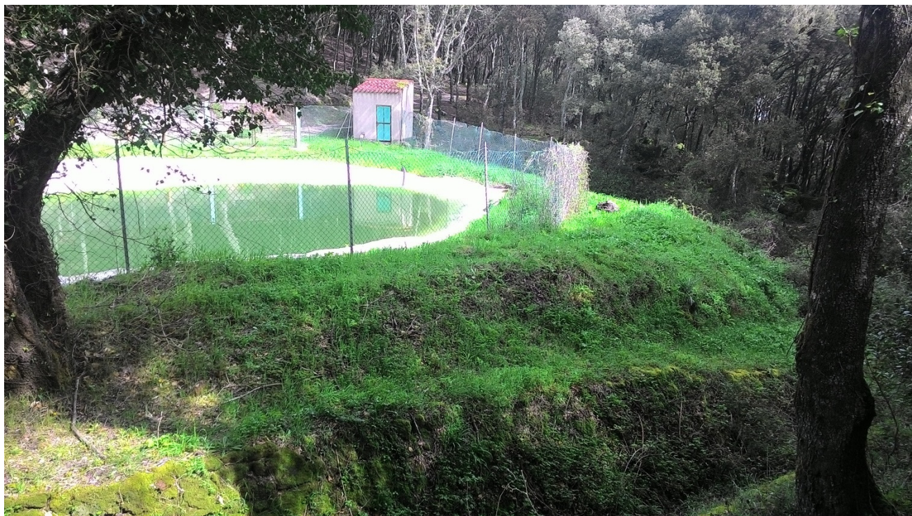
Fig. n. 15 – Punto di scatto n. 3 – stato attuale
