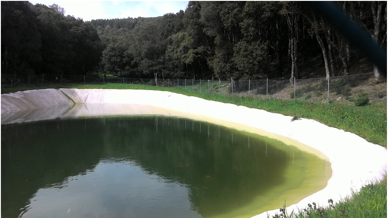
Fig. n. 10 – Punto di scatto n. 1 – stato attuale
