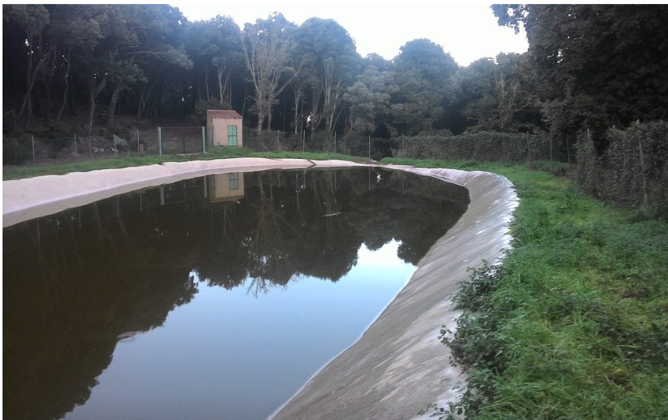
Fig. n. 12 – Punto di scatto n. 2 – stato attuale
