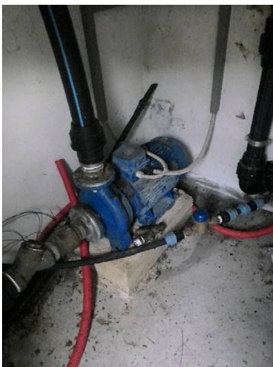
Foto n. 11, 12, 13 – Pompa di aspirazione, elettrovalvole per impianto di irrigazione fasce umide con relativo spruzzatore
