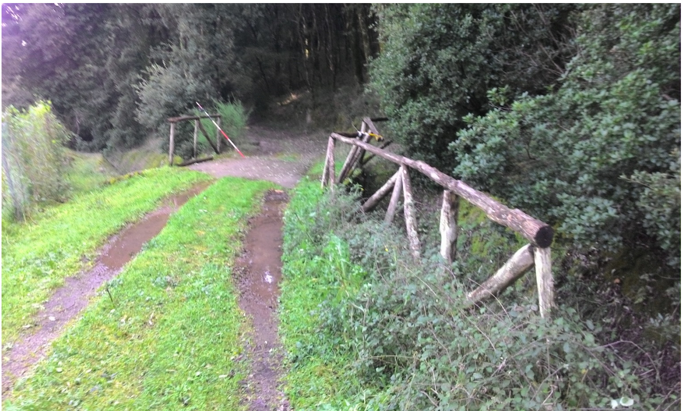
Foto n. 15 – Staccionata sul ponticello sul diversivo del Riu Sennisceddu, a lato dell'invaso
