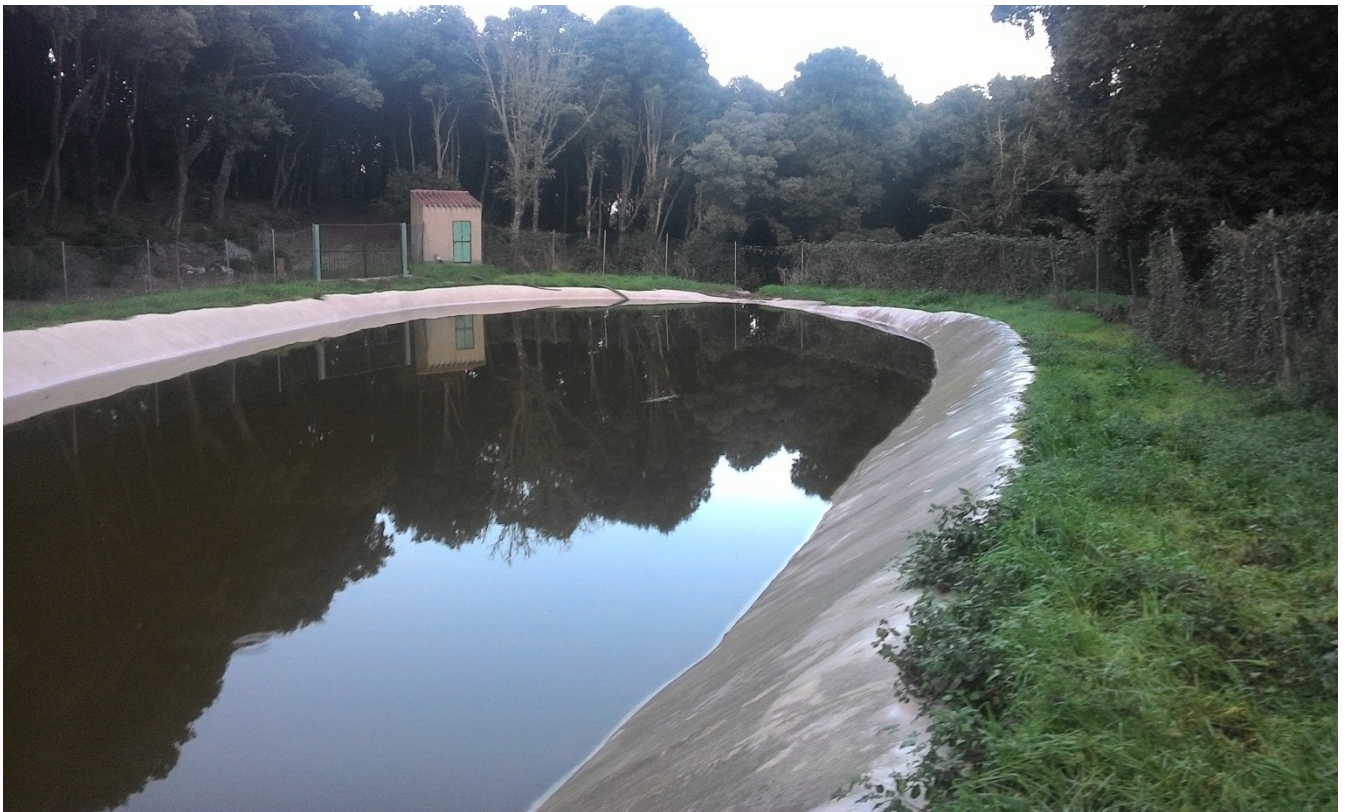
Foto n. 3 – Paramento di valle e locale tecnico
