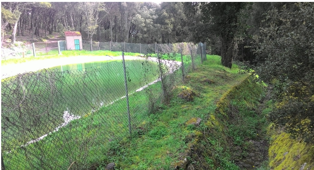
Foto n. 7 – Diversivo del Riu Sennisceddu che costeggia l'invaso lateralmente in destra idraulica
