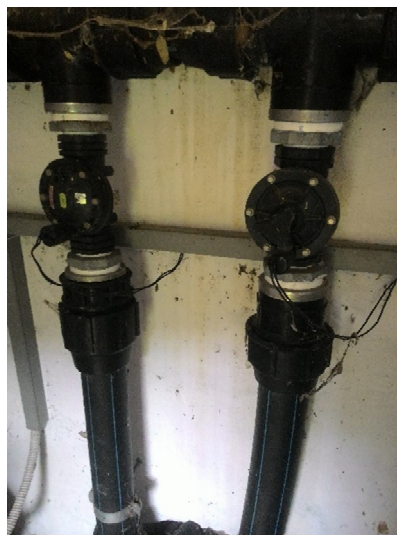
Foto n. 11, 12, 13 – Pompa di aspirazione, elettrovalvole per impianto di irrigazione fasce umide con relativo spruzzatore
