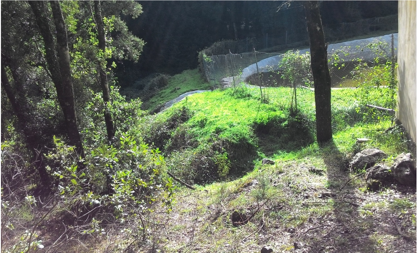
Foto n. 4 – Paramento di vale, scarico superficiale e canale fuggatore, visti dalla sinistra idraulica
