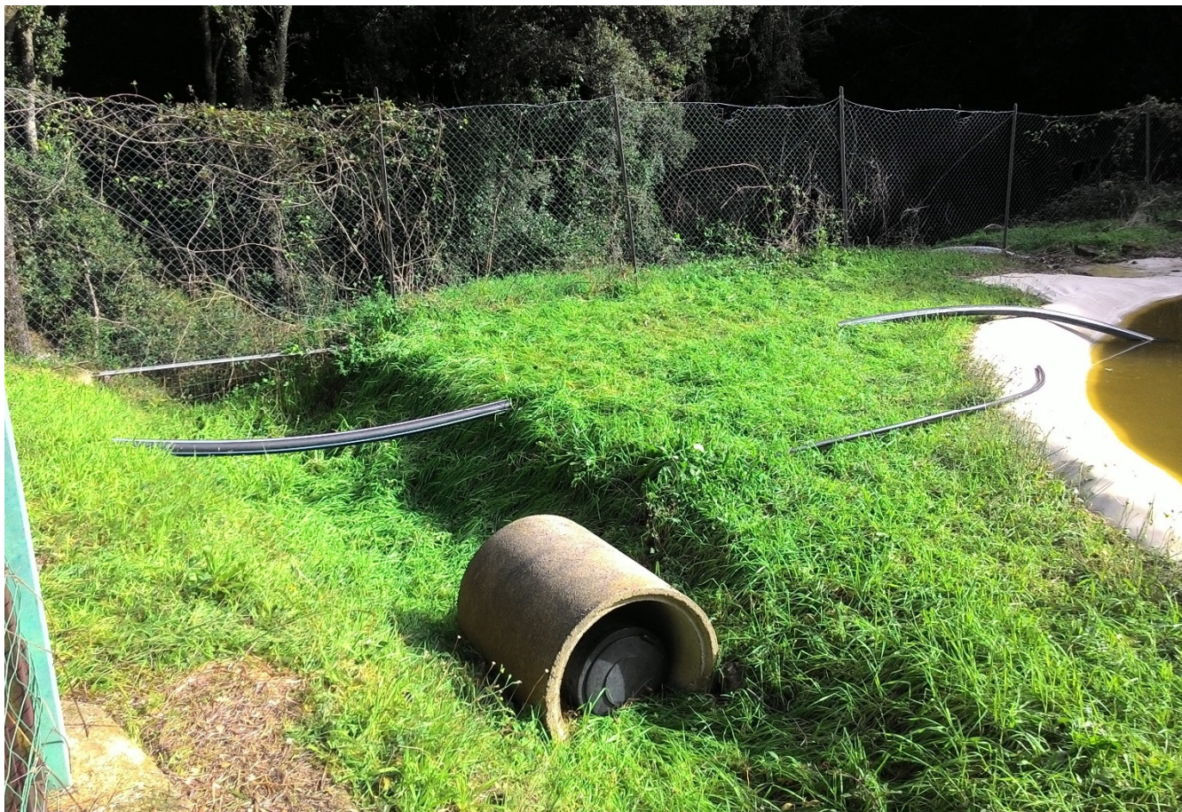
Foto n. 6 – Particolare del canale fuggatore e delle condotte per approvvigionamento e aspirazione di acqua dall'invaso
