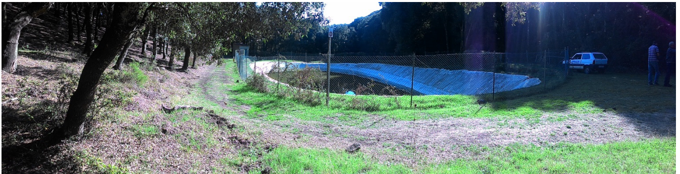
Foto n. 2 – Panoramica dell'invaso visto da monte, sulla sinistra idraulica
