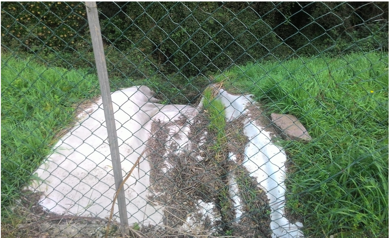
Foto n. 5 – Particolare dello scarico superficiale , visto da monte
